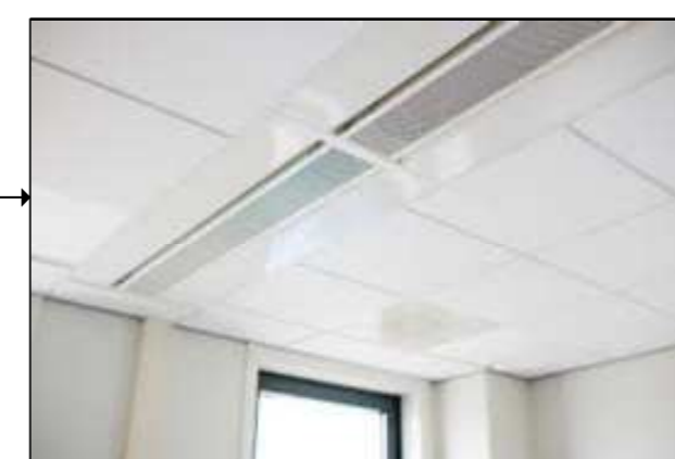
Inductie-units in verlaagd plafond
