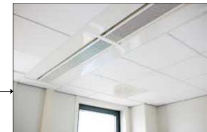
Inductie-units in verlaagd plafond
