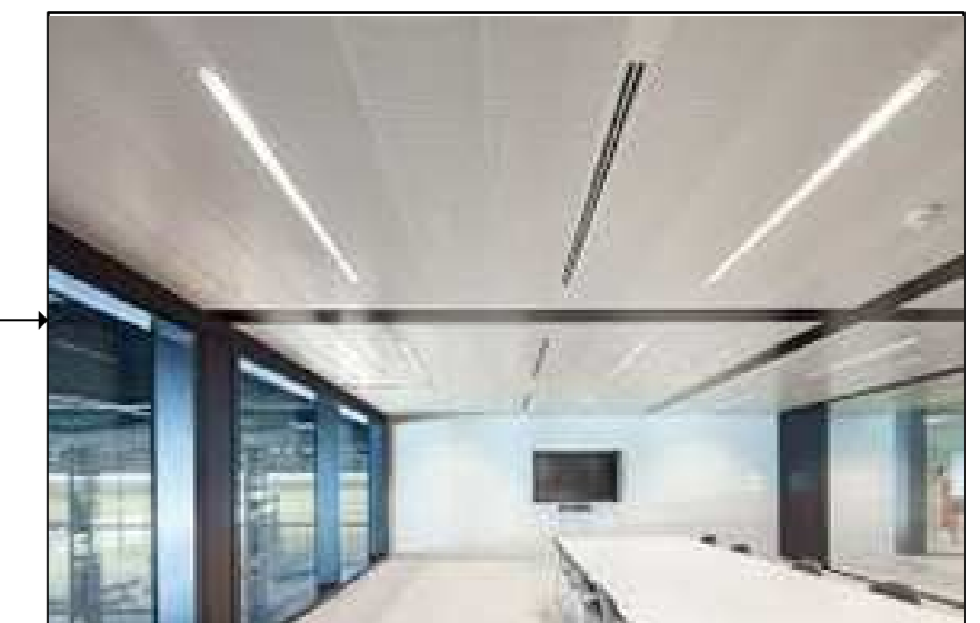
Klimaatplafond in combinatie met LED-verlichting
