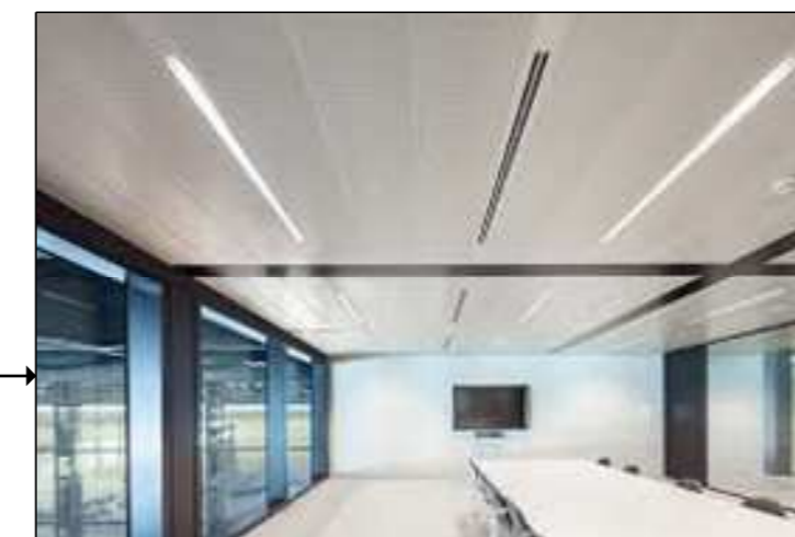
Klimaatplafond in combinatie met LED-verlichting
