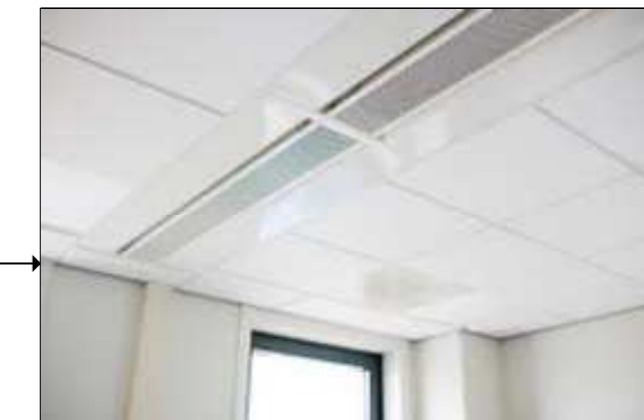
Inductie-units in verlaagd plafond
